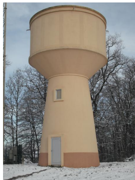
Réservoir Dannemarie sur Crête
